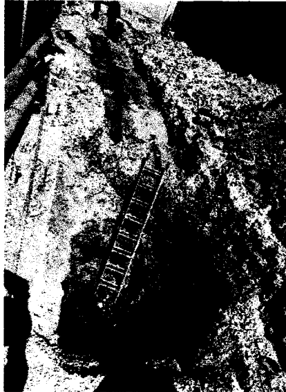
FOTO N°11: Se realizan los trabajos de excavación para cámara de bombeo. Área de Recepción.
